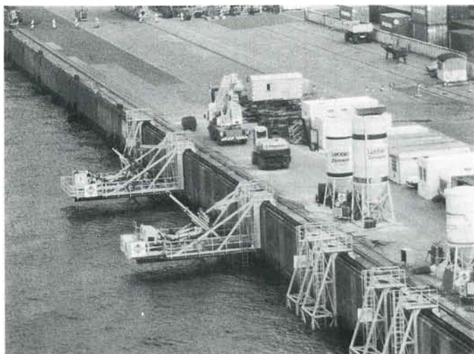
Abb. 4: Verankerung der Kaimauer am 8. Liegeplatz
