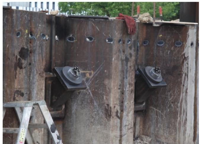
Bild 2: Vorgespannte Daueranker vor Montage der Stahlschutzhauben
