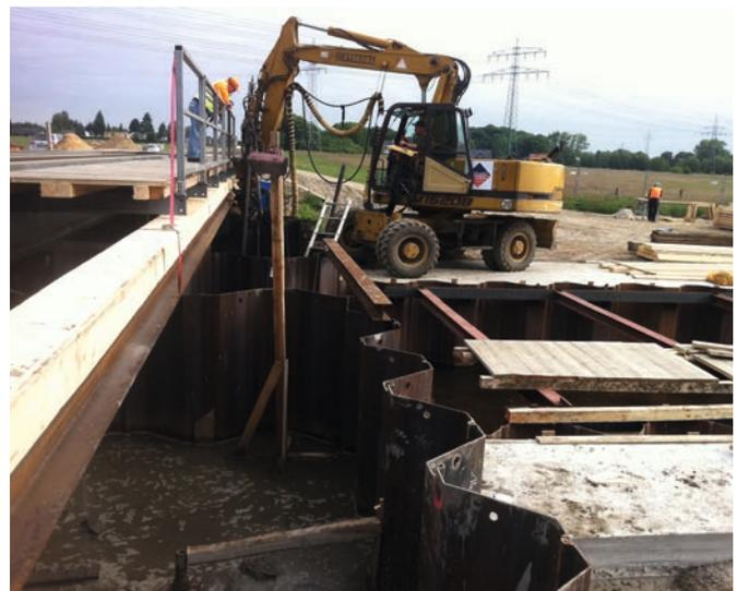
Bild 3: Mobilbagger mit angebauter Bohrlafette
