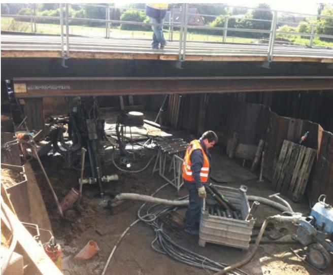
Bild 2: Kellerbohrgerät unter den Schienen
