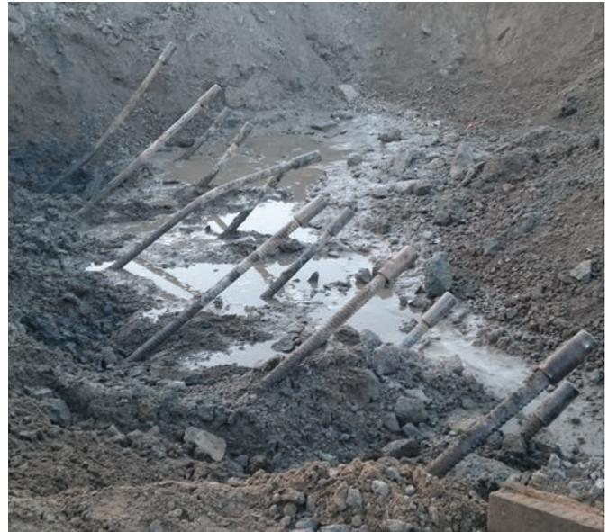
Bild 3: Beschädigte Mikropfähle
