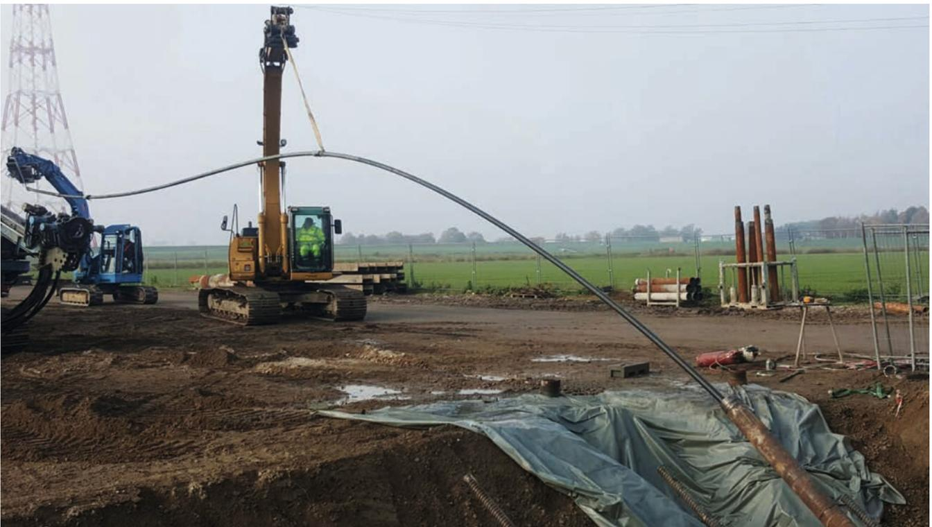
Bild 5: Ausbau des nackten GEWI-Stahles mit Hilfe eines Kettenbaggers
