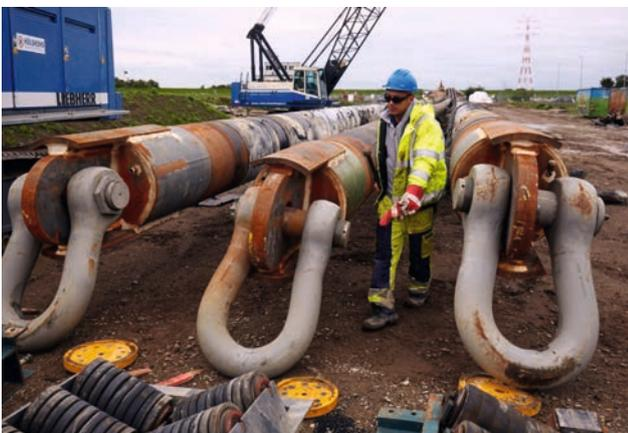
Bild 1: Montierte Schäkkel am alten Düker
