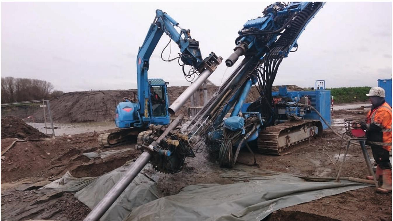
Bild 4: Überbohren der Zugpfähle mittels Überlagerungsbohrung
