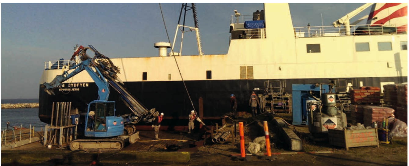
Bild 1: Einbau eines GEWI 57,5 mm Einstabankers am Fähranleger Bøjden
