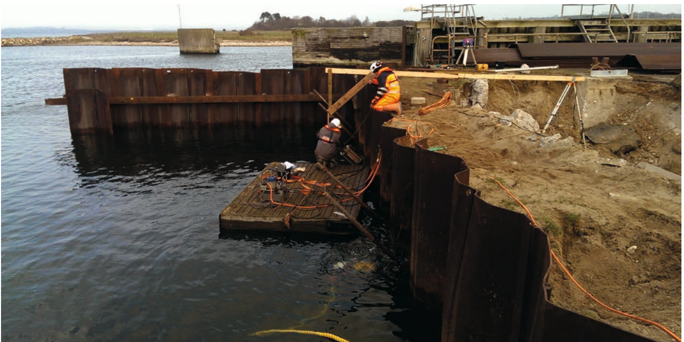
Bild 2: Wasserseitiges Prüfen und Vorspannen eines Dauer-Einstabankers Typ GEWI 57,5
