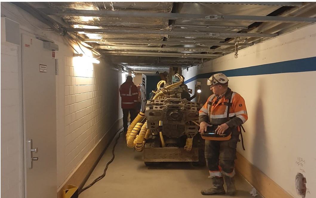
Abb. 3: Liefergang zum Baufeld in der Gewölbehalle. Fotograf: Stefan Doll.
