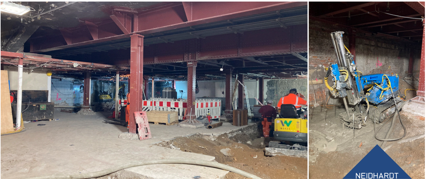
Abb. 1+2: Gewölbehalle, Hannover Hauptbahnhof / Morath Bohrraube BR 3000. Fotograf: Lorenz Dörwald.
