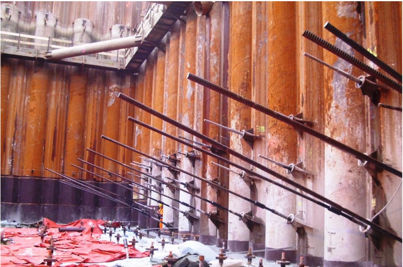
Bild 6: Vorgespannte und verlängerte Verpresspfähle untere Verankerungslage
