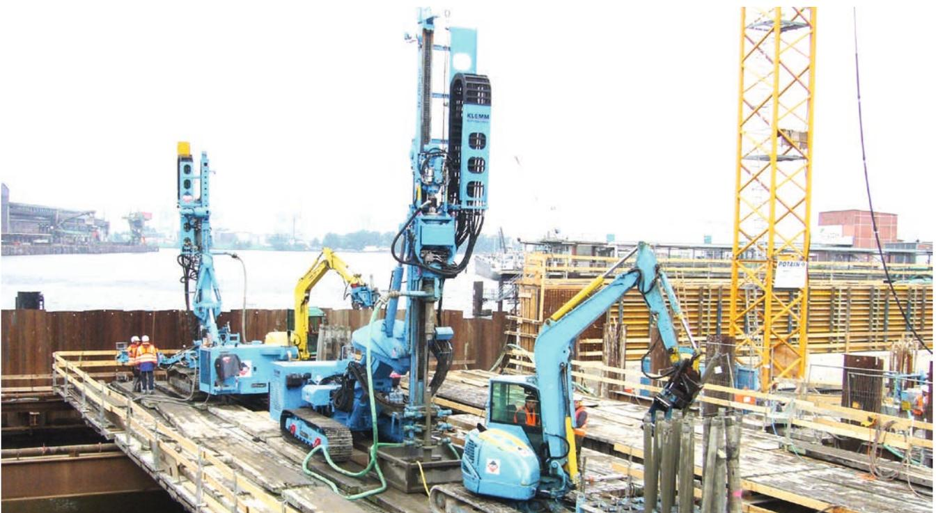
Bild 4: Herstellung von Vertikalbohrungen mit zwei Geräteeinheiten
