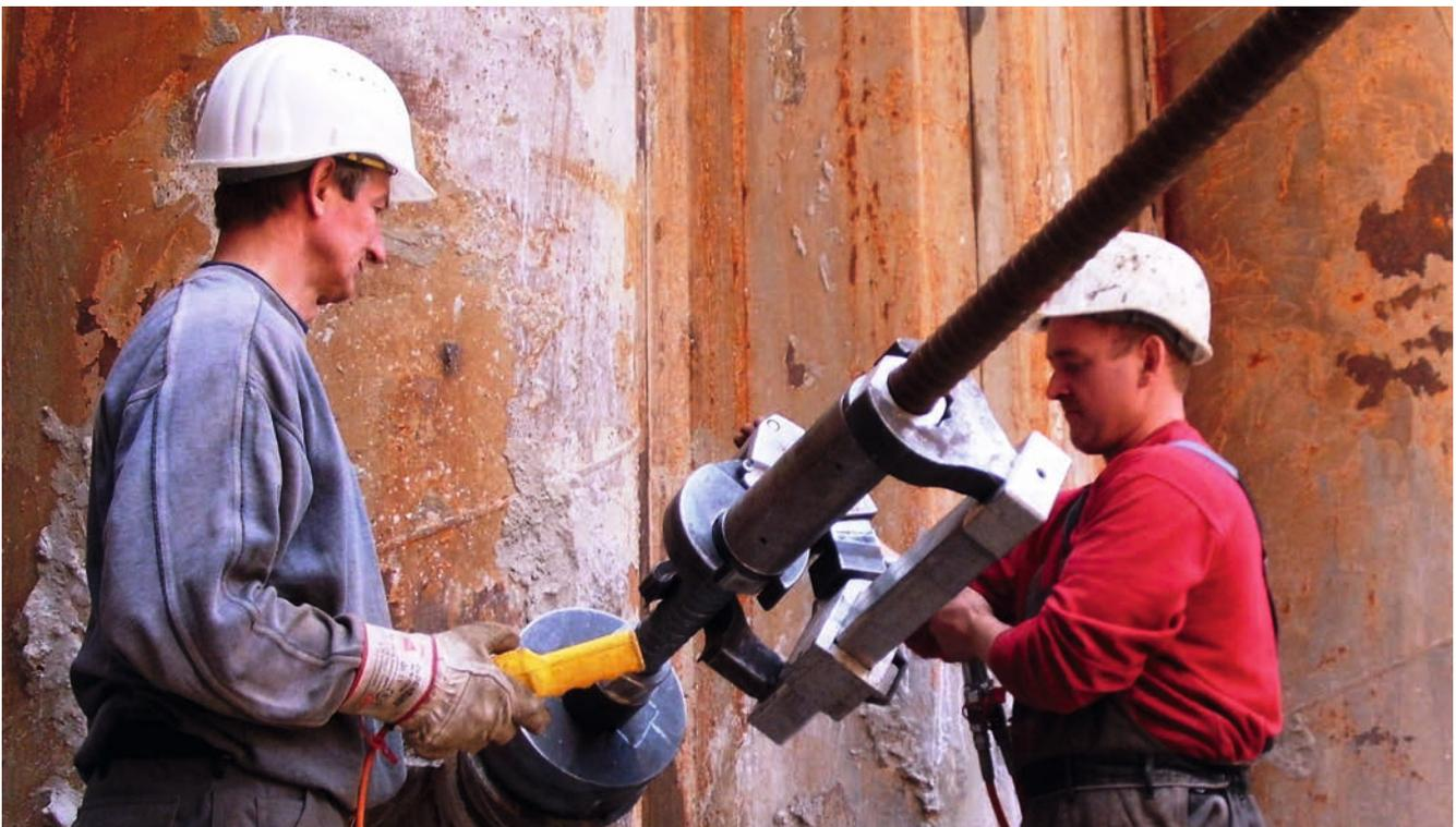
Bild 7: Konterung eines GEWI-Stabes mithilfe eines Kontergerätes
