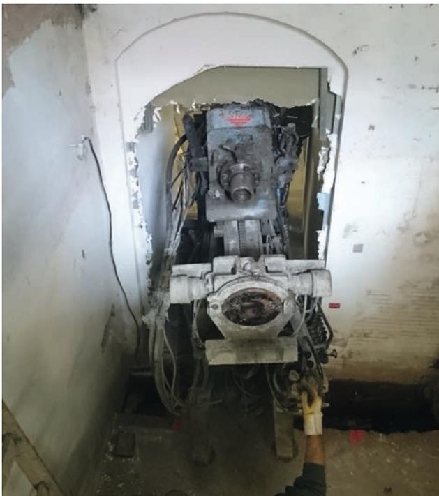
Bild 1: Einsatz des Kellerbohrgerätes „Hütte 202“ unter beengten Verhältnissen
